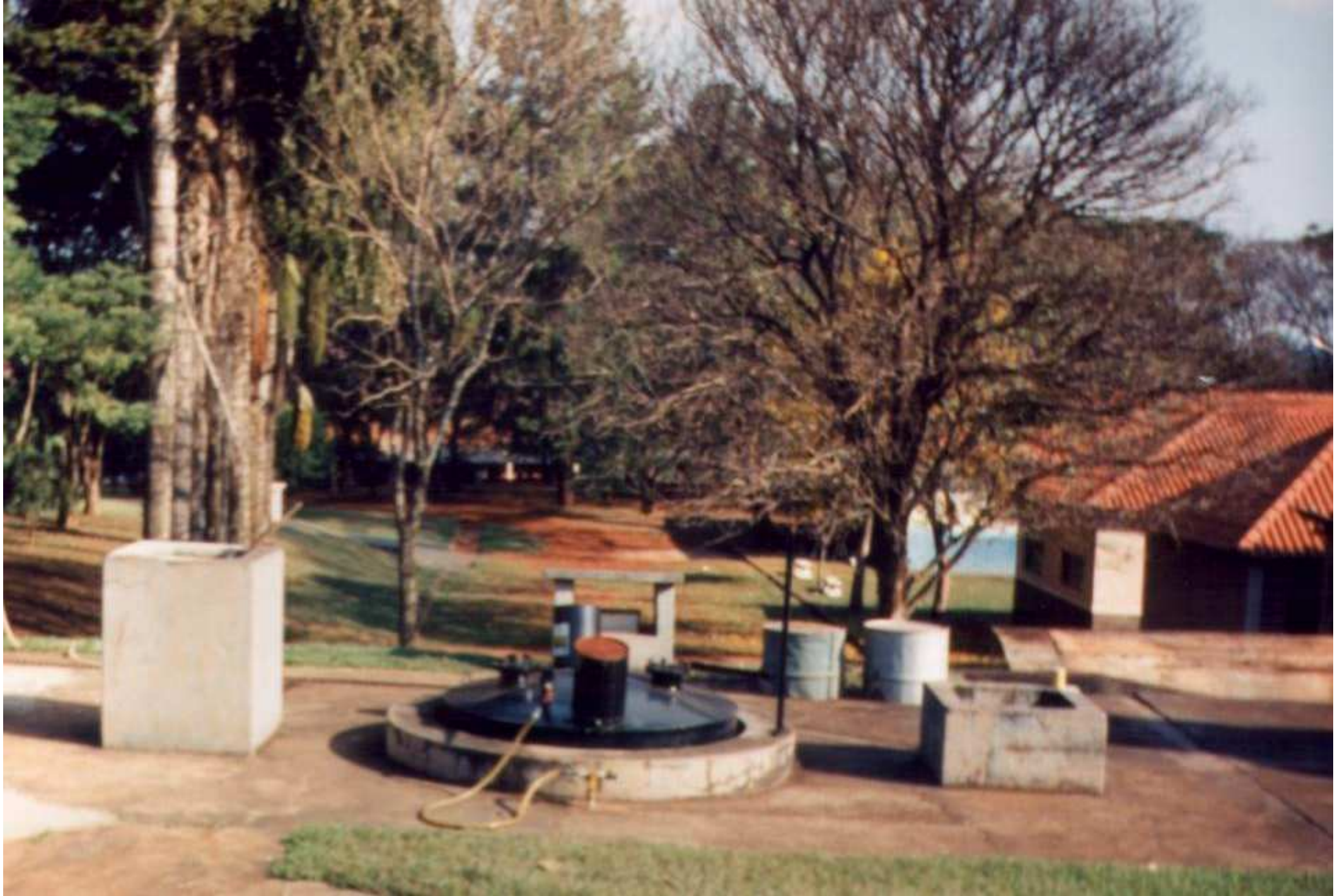
Biodigestor contínuo modelo Indiano Depto. de Eng. Rural / UNESP - Jaboticabal.
