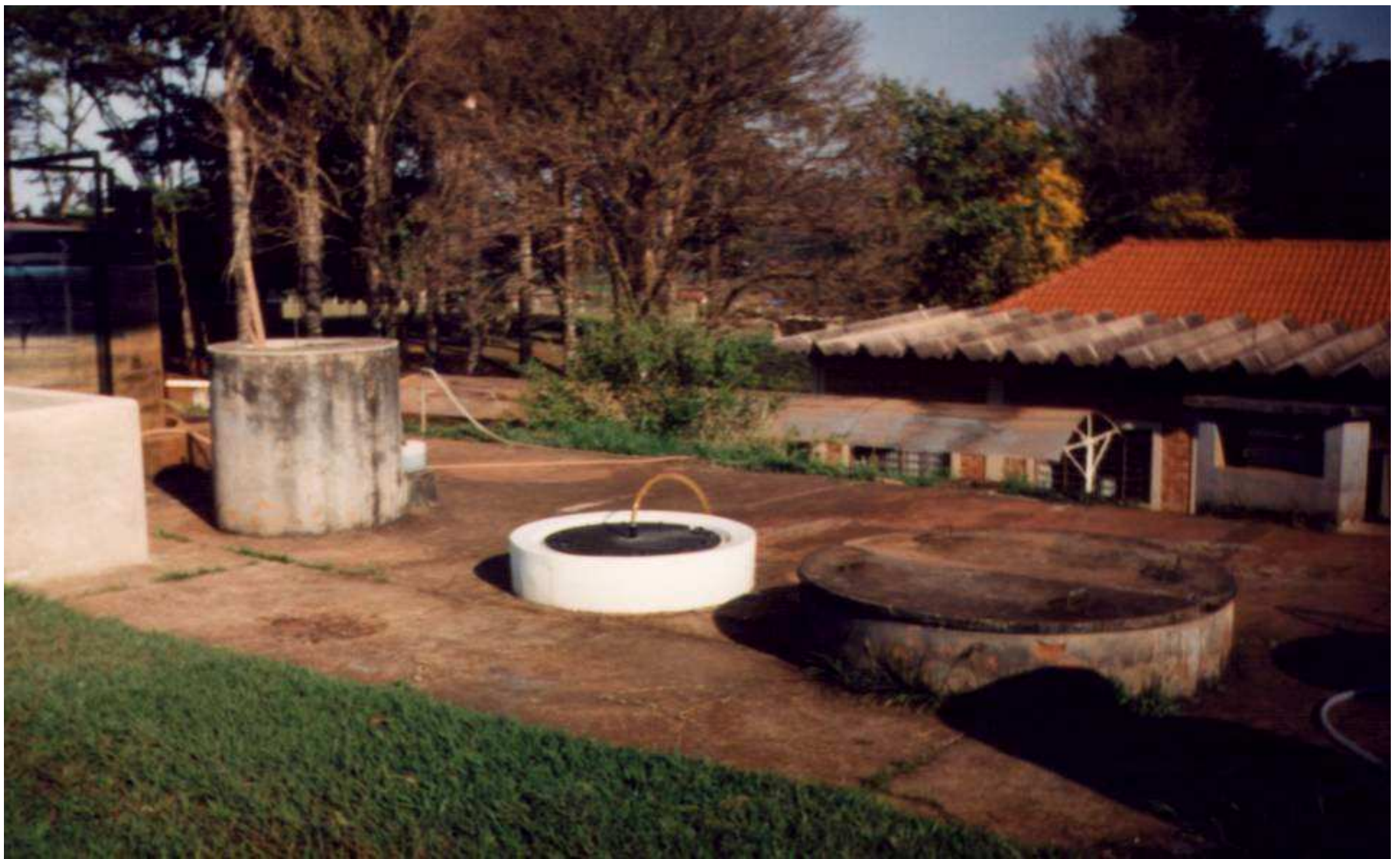
Biodigestor contínuo modelo Chinês Depto. de Eng. Rural / UNESP - Jaboticabal.
