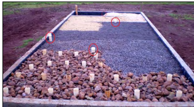
Figura 2: Canos de inspeção instalados.
